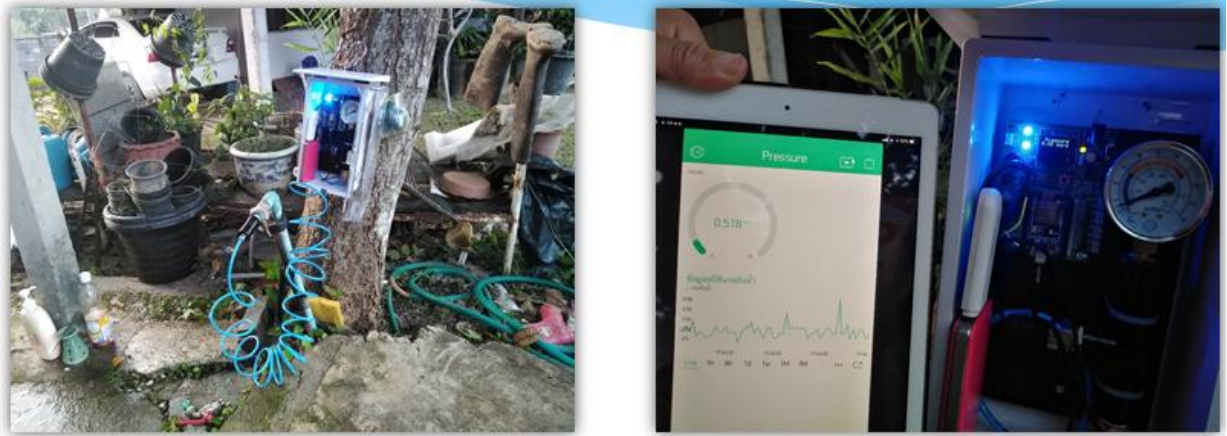
ติดตั้งเครื่องบันทึกการเข้าถึงก๊อกน้ำบ้านผู้ใช้
