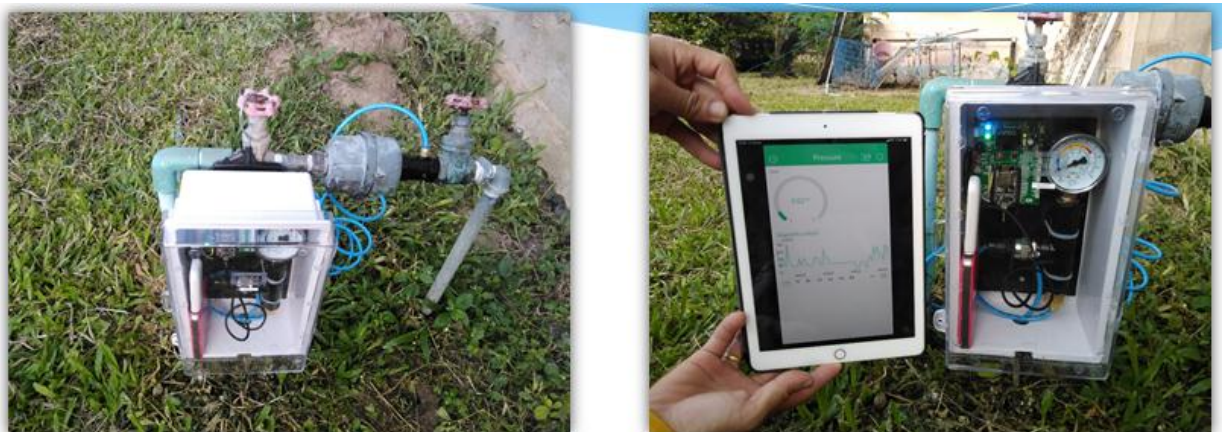
ติดตั้งเครื่องบันทึกฯเข้ากับขามมาตรวัดน้ำของผู้ใช้น้ำ
