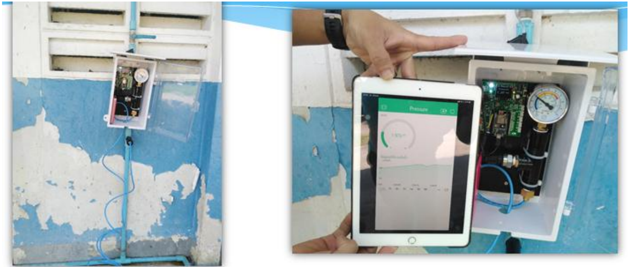
ติดตั้งเครื่องบันทึกการเข้าถึงระบบประปาภายในอาคารของลูกค้า
